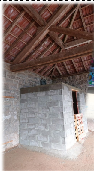
Travaux local vélos scolaires
