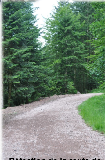
Réfection de la route de la Mousse
