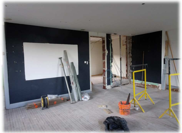
Travaux bureaux Mairie
